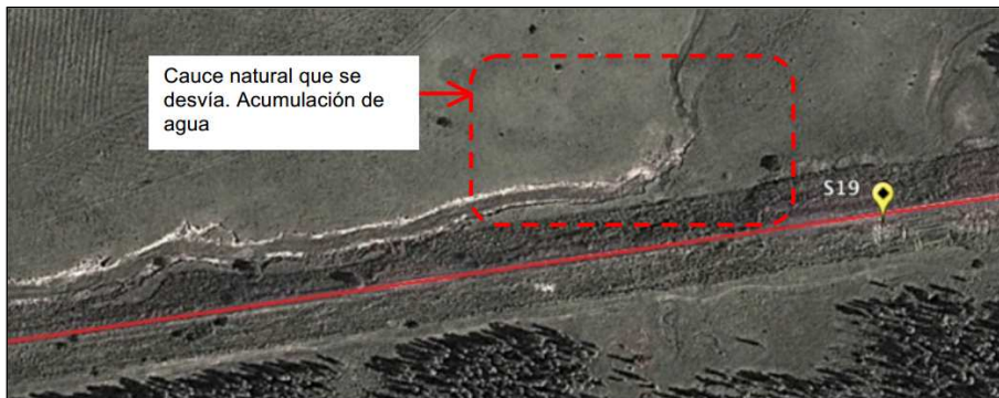
Figura 3. - Sector con acumulación de agua.
