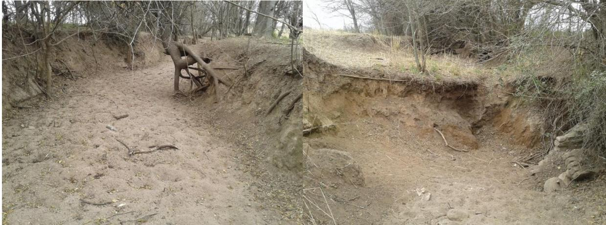
**Figura 9** Izquierda: erosión lateral en traza de acequia Los Molles . Carga de fondo arena y gravilla. Derecha: restos de obras del canal afectados por erosión.
