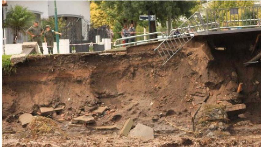
Fig. 13. Fuerte erosión de margen derecha y afectación de estribo del puente Colón 2015.
