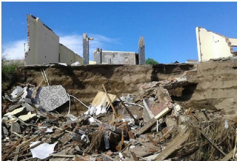
Fig. 17. Bº Agua Mansa severa erosión de márgenes con afectación de infraestructura urbana.
