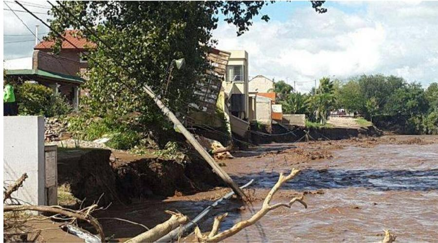
Fig. 11. Bº Las Vertientes. Calle costanera y viviendas afectadas por desbordes y erosión de márgenes 2015.
