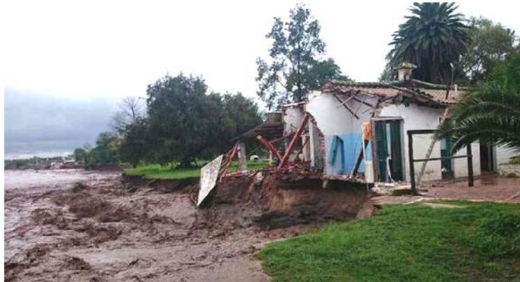
Fig. 15. Severa erosión de margen derecha Ea. Agua Mansa.
