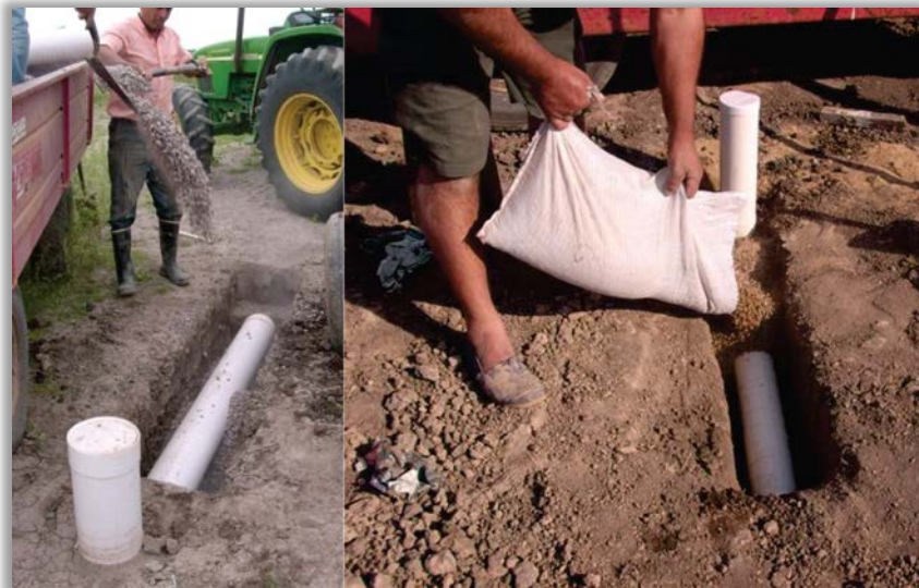
Figura 5.52. Armado del Prefiltro de grava.
