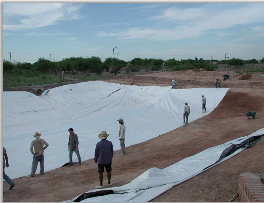
Figura 5.5. Impermeabilización de represa. Fuente INTA- Basan (2010).
