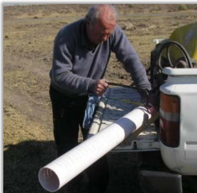
Figura 5. 38. Construcción de un filtro con ranura horizontal.
