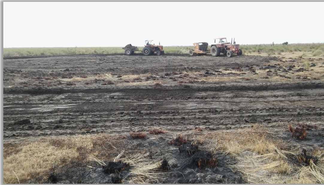
Figura 5. 13. Inicio de obra.
