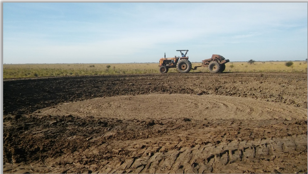
Figura 5. 14. Vista del tanque construyéndose en su fase terminal.
