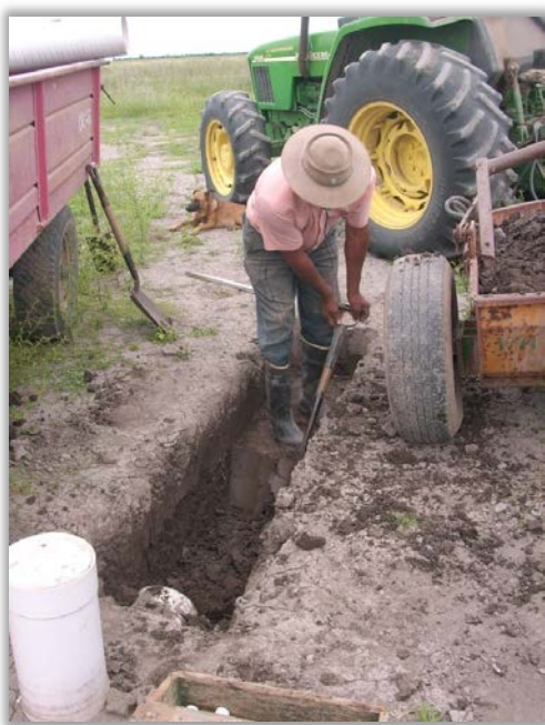
Figura 5.50. Zanja para ubicación del Prefiltro y Filtro horizontal.
