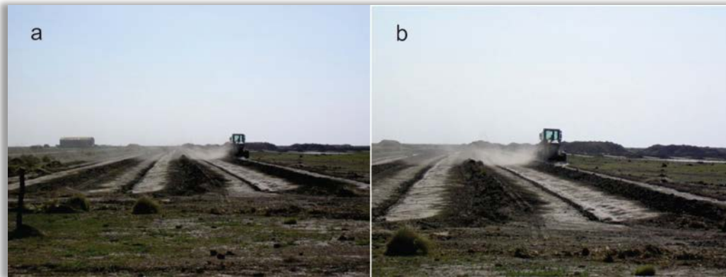
Figura 5.17. a) y b). Movimiento de suelo para la construcción de camellones.
