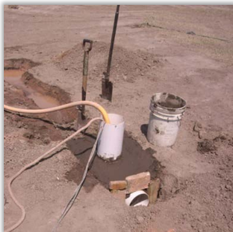
Figura 5.49. Cementado del brocal.
