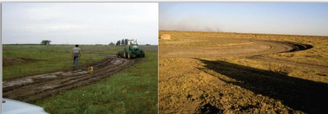
Figura 5.46. Preparación del sector de almacenamiento.
