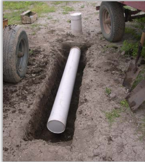
Figura 5.51. Ubicación del Filtro lateral
