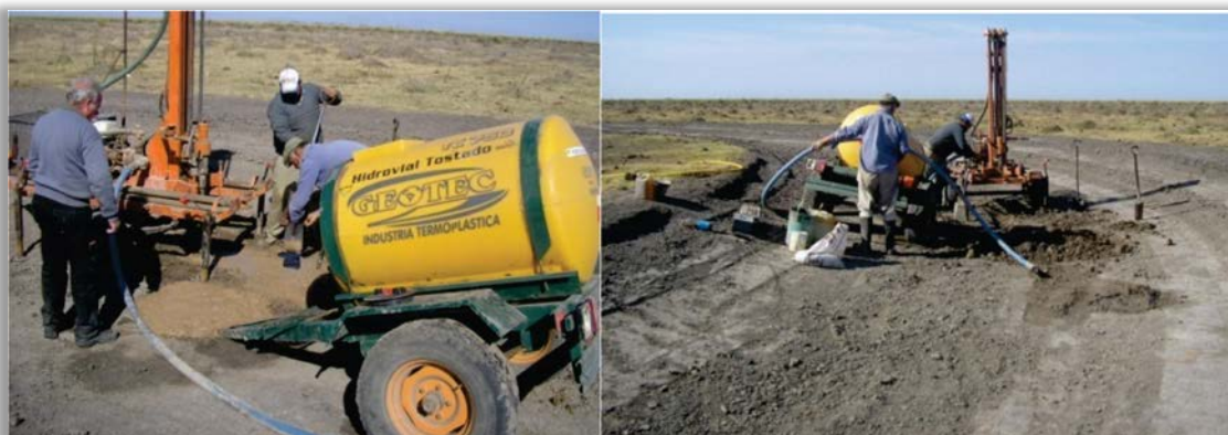
Figura 5.47. Perforación de los pozos.
