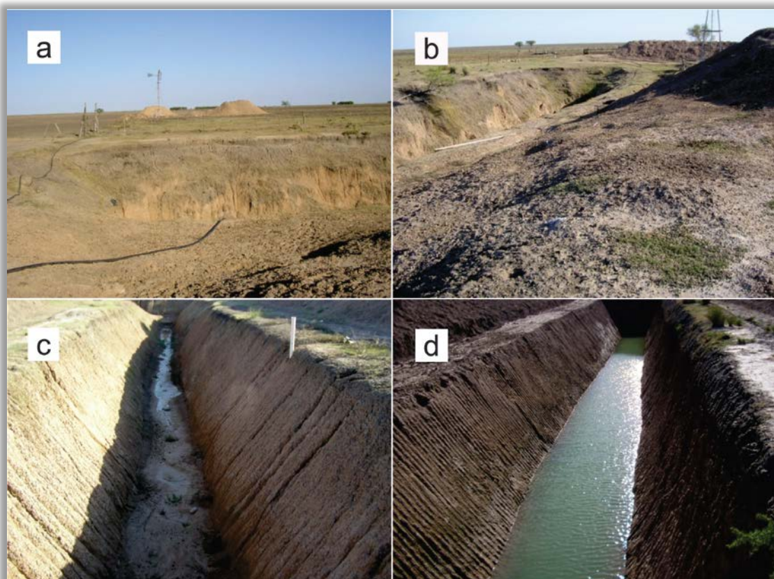
Figura 5.26. a, b, c, d. Represas que captan la freática.
