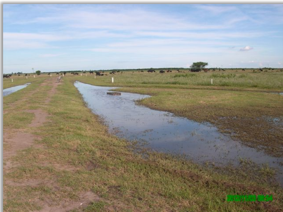
Figura 5.6. Cunetas colectoras a los lados de los caminos internos.
