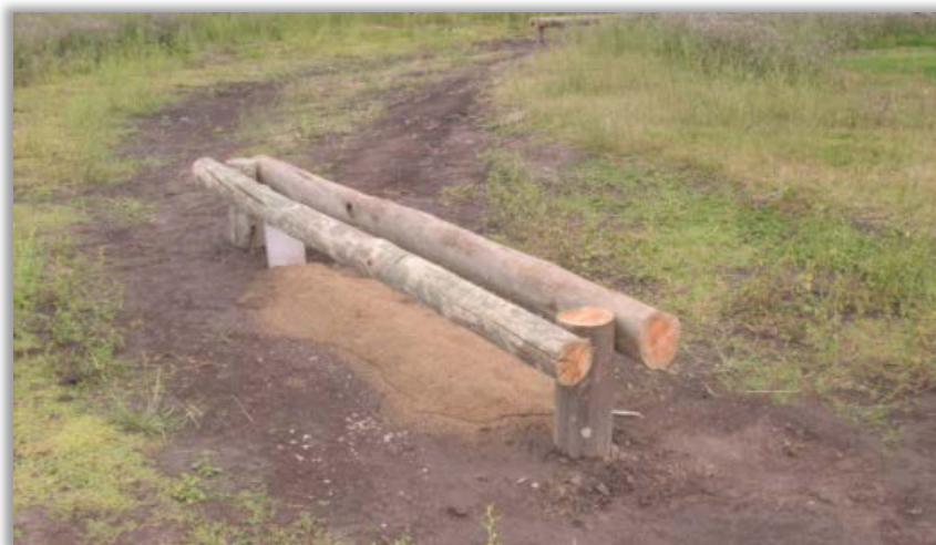
Figura 5.54. Protector del pozo y filtro horizontal para evitar roturas.
