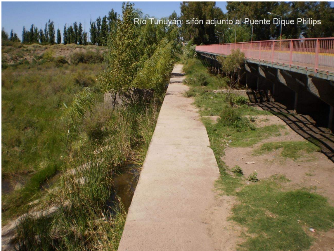
Figura 6.6.36. Fotografía desde aguas abajo del puente del Dique Philips que muestra el conducto del sifón
