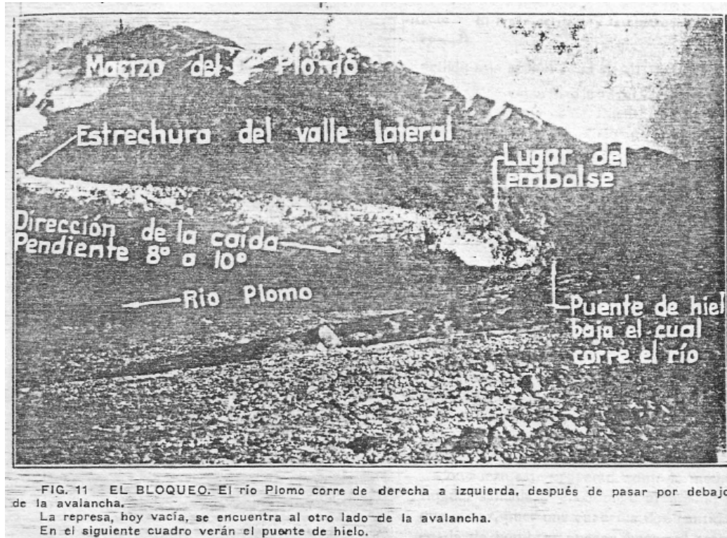
Figura 10. Fotografía desde aguas abajo del endicamiento glaciar en 1934 que muestra la pendiente del coronamiento desde margen derecha a izquierda (King, W.D.V.O., 1934)
