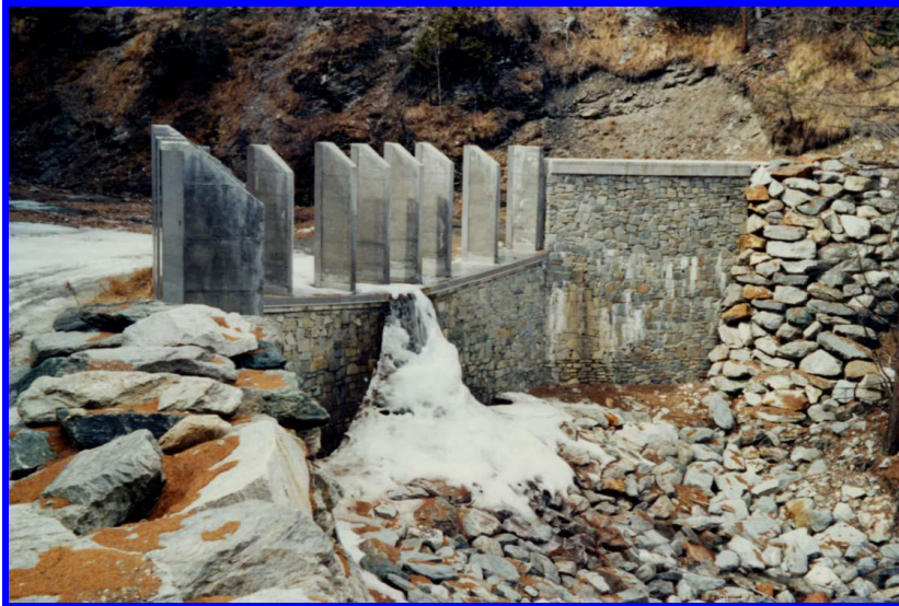
Figura 10-5 Obras de retención de materiales sólidos de gran volumen
