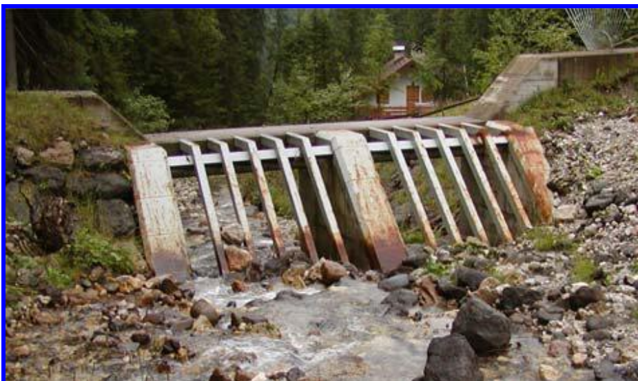
Figura 10-7 Obras de retención de materiales sólidos de gran volumen
