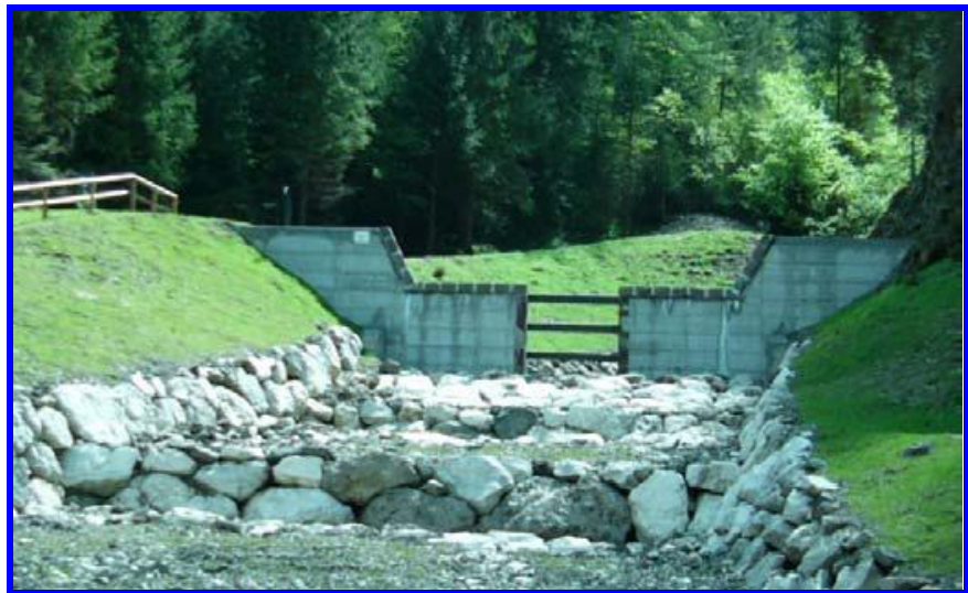
Figura 10-6 Obras de retención de materiales sólidos de gran volumen
