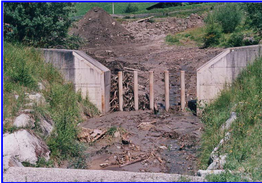
Figura 10-8 Obras de retención de materiales sólidos de gran volumen
