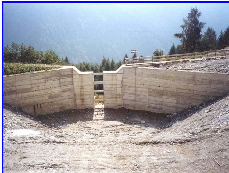
Figura 10-4 Obras de retención de materiales sólidos de gran volumen
