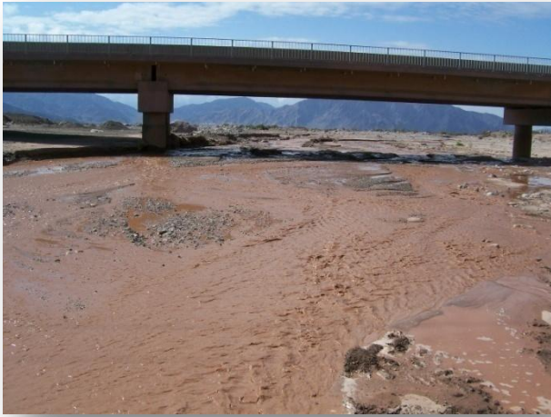
Imagen 11. Río Troya Puente Ruta 60 (Aforo 3)
