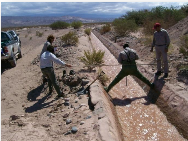
Imagen 13. Canal Guanchín - La Ramadita (Aforo 5)
